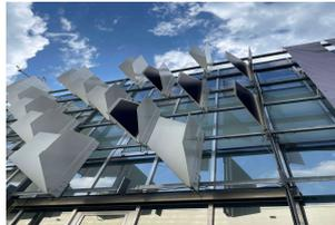
Die Strelitzie ist ein Beispiel für die Reduzierung von Reibung und Verschleiß. Die Blüte wird über einen Klappmechanismus geöffnet, sobald sich ein Vogel auf den Rand setzt. Daraus entwickelte Fassadenverschattungen kommen ohne Scharniere aus, wodurch Verschleiß und Reibung reduziert werden. Dadurch sind sie langlebiger und wartungsarm.
