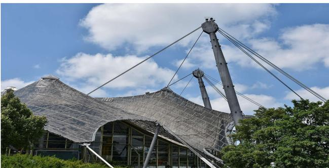
Das Seil als Konstruktionselement kann Zugkräfte aufnehmen und übertragen. Zahlreiche Leichtbaukonstruktionen nach dem Vorbild der Natur wurden in bekannten Bauwerkskonstruktionen umgesetzt.
