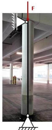
Die Lagerung entspricht mit einem Fest- und einem Loslager dem Eulerfall 2. Unten sollten die Stützen fest eingespannt werden, oben gelenkig, um eine Ausdehnung zu ermöglichen und Spannungen zu verhindern. Das System ist somit statisch bestimmt.
