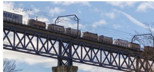
Strebenfachwerk mit einer Stütze
