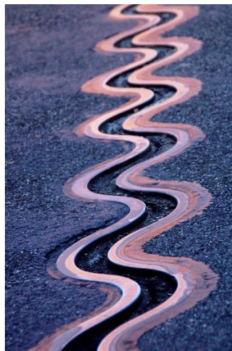
Abbildung 68: Dehnungsfuge auf einer Brücke
