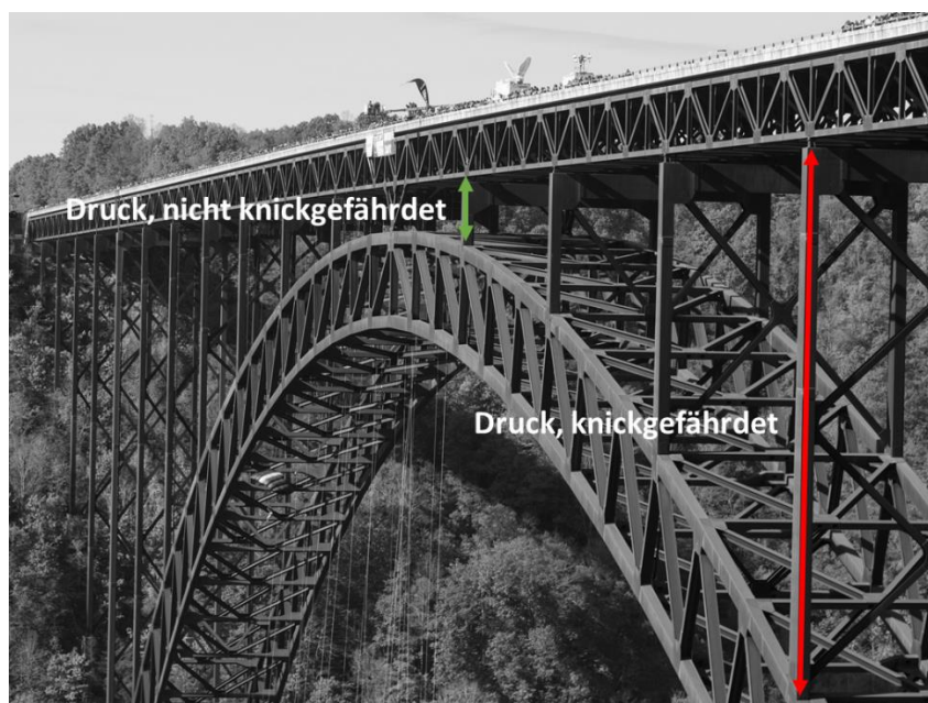
Abbildung 75: Knickgefährdete Bauteile
